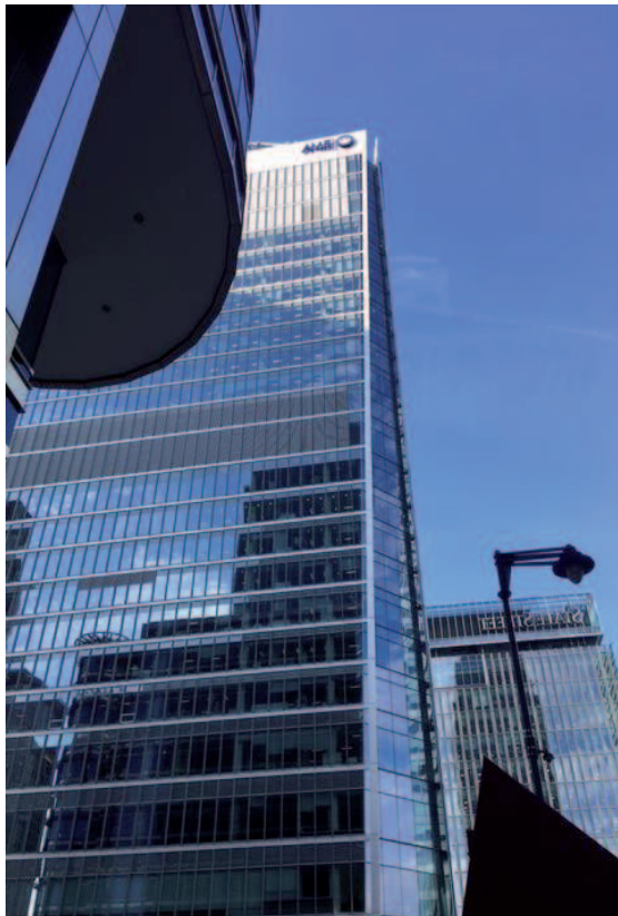
Gebäude der EMA in London
